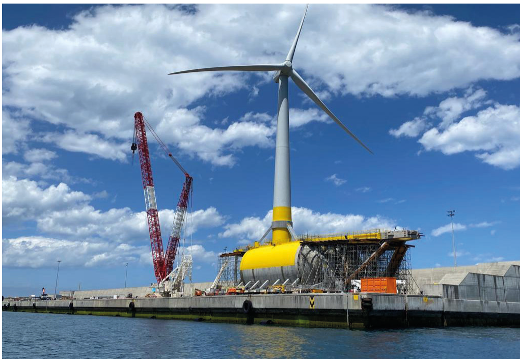
Proceso de construcción de una Unidad Móvil de Energías Renovables Marinas (MORU), estructuras clave en la transición energética que plantean nuevos desafíos para el derecho marítimo internacional.
